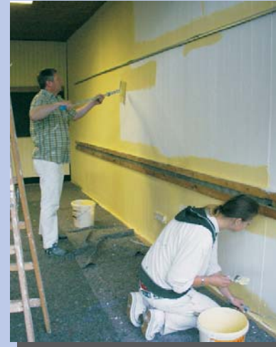
Renovierung von Klassenzimmern
